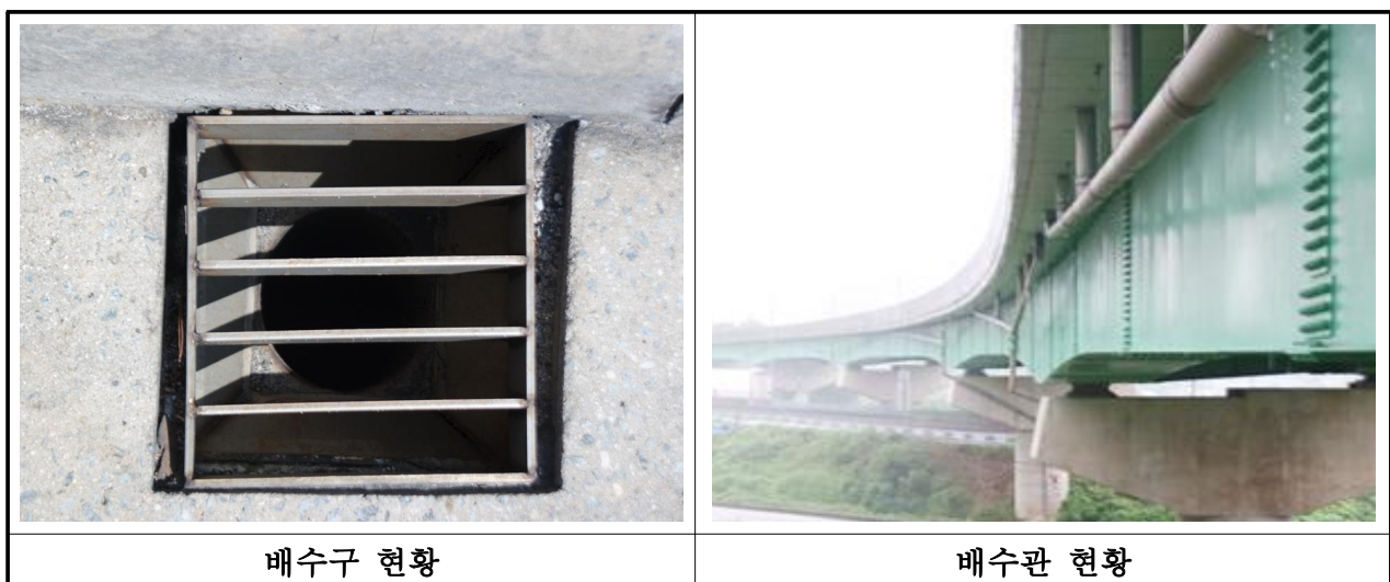
【사진 3.20】 배수구 및 배수관 전경
