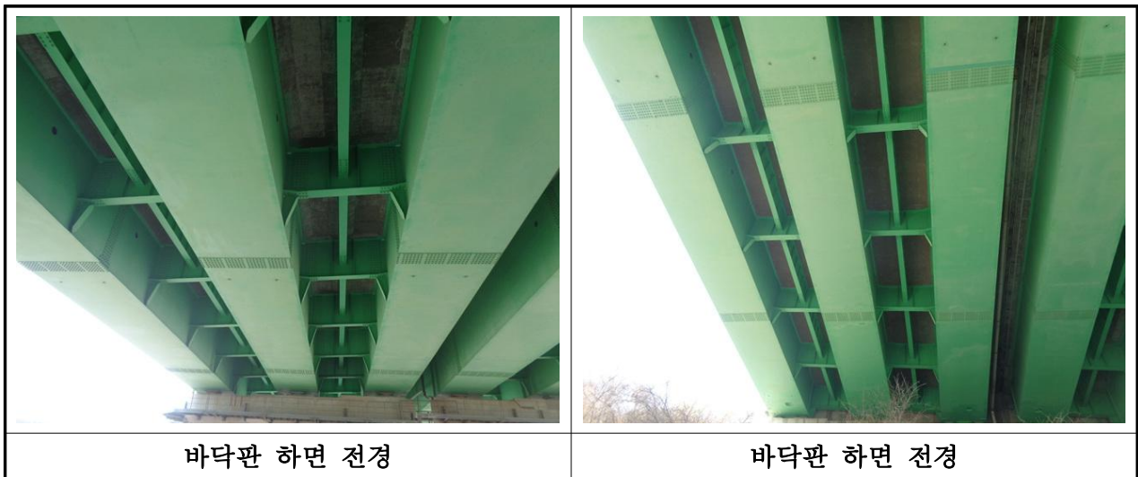
【사진 3.24】 바닥판 전경
