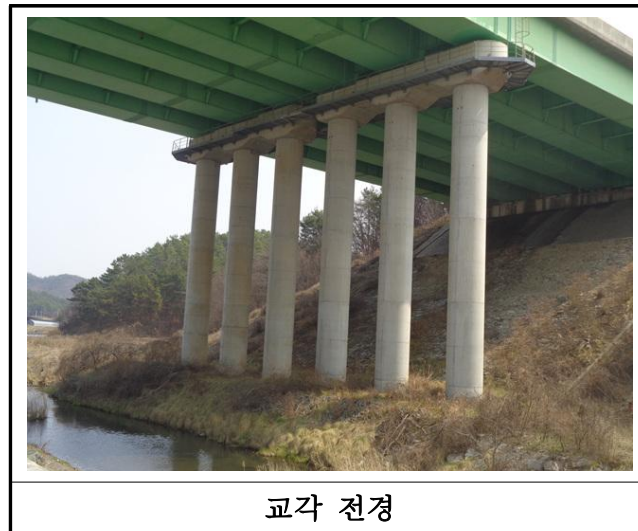
【사진 3.33】 교각 전경
