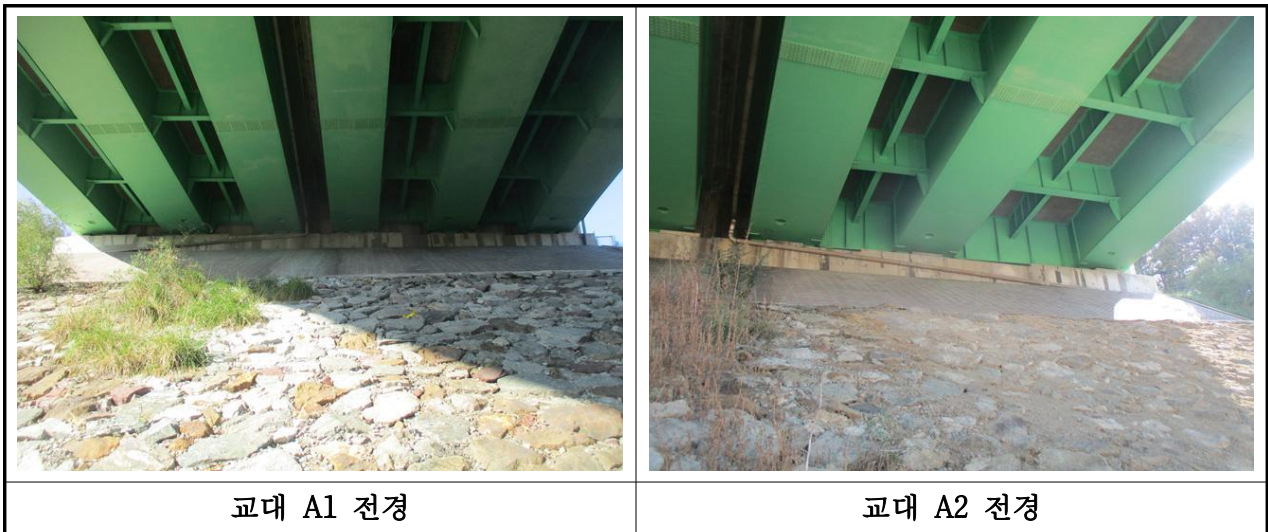
【사진 3.31】 교대 전경
