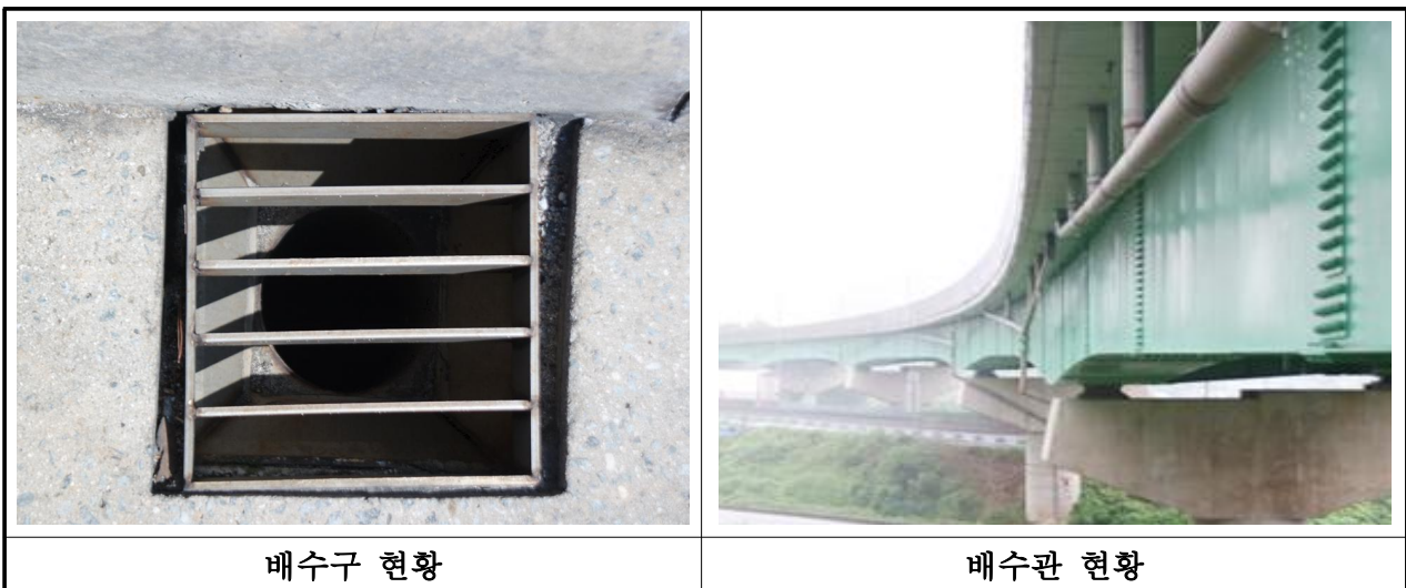
【사진 3.42】 배수구 및 배수관 전경
