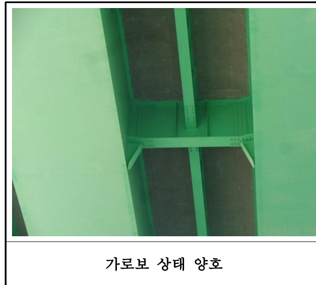
【사진 3.8】 가로보 및 세로보 손상현황
