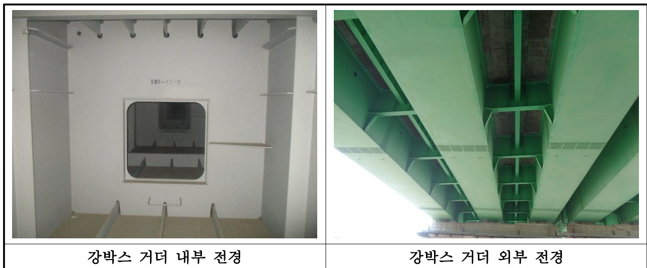
【사진 3.4】 강박스 거더 전경
