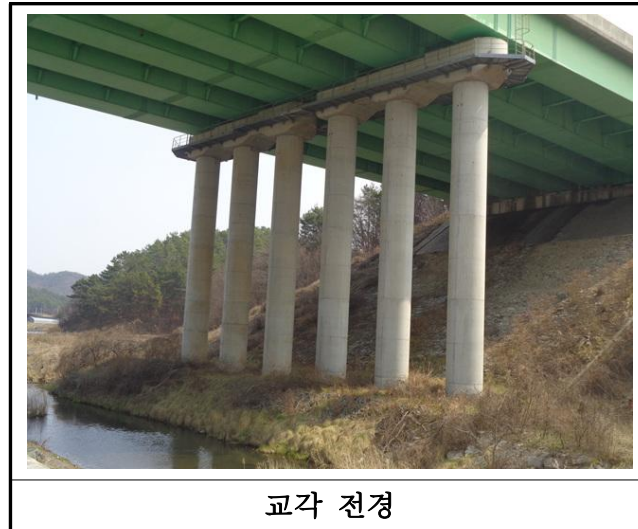
【사진 3.11】 교각 전경
