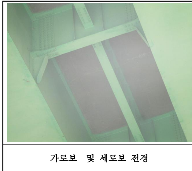
【사진 3.29】 가로보 및 세로보 전경
