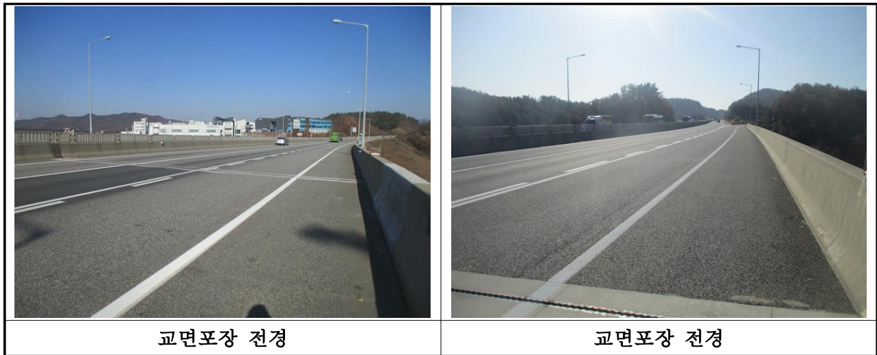
【사진 3.18】 교면포장 전경
